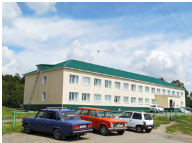
Здание районной поликлиники
