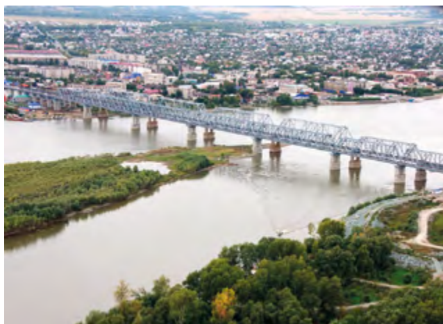
Железнодорожный мост через Обь
