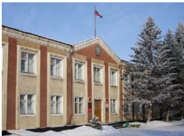
Здание районной администрации
