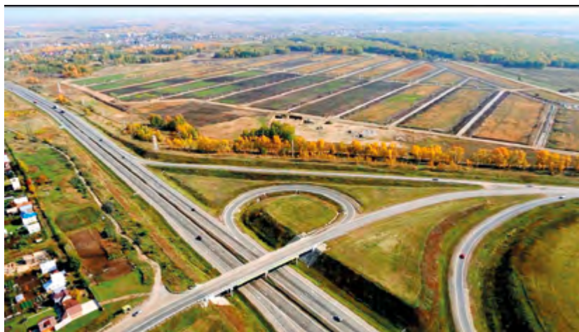
Развязка федеральной трассы М-52, проходящей по Первомайскому району
