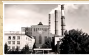
Барнаульская ТЭЦ-2. Строительство начато в 1950 г. Первые котел и турбина были пущены в 1955 г.
