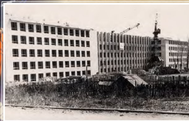
Строительство Политехнического института
