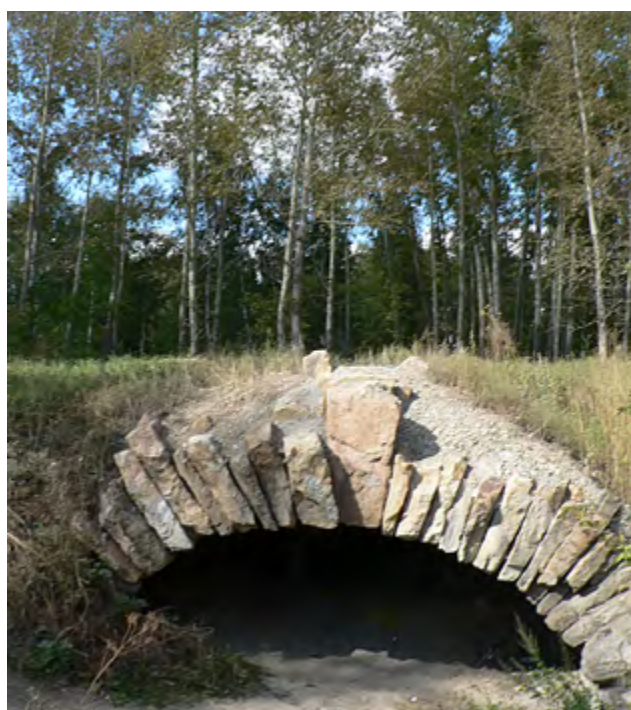
Вход в «Екатерининскую» штольню Змеиногорского рудника
