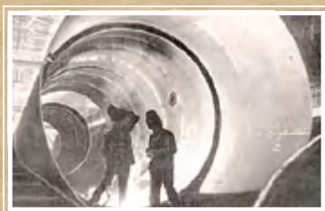
В цехах Барнаульского котельного завода
