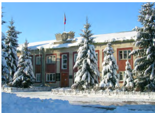
Здание районной администрации
