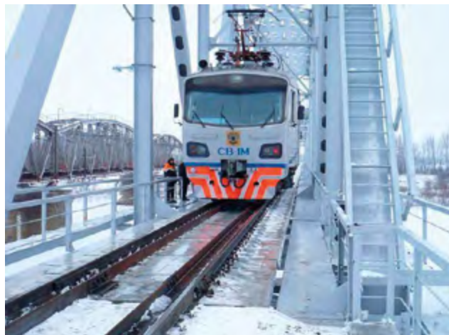
Железнодорожный мост через реку Чумыш
