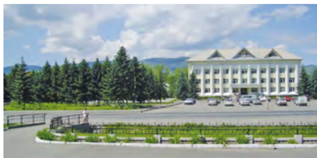
Здание районной администрации
