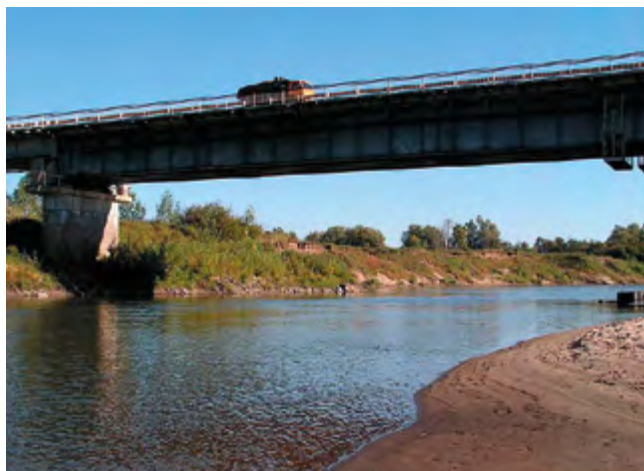
Трасса Алтай-Кузбасс, мост через р. Чумыш
