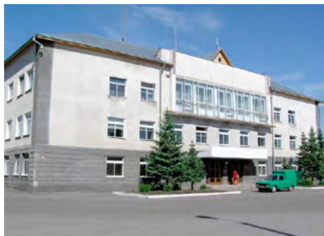
Здание районной администрации
