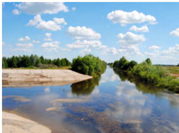
Кулундинский магистральный канал
