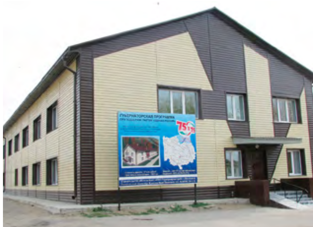
Поликлиника «Усть-Калманской ЦРБ» после капитального ремонта по Губернаторской программе «75х75»
