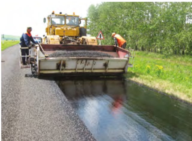
Ремонт дорожного покрытия у с. Шульгин Лог
