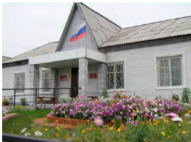
Здание управления Пенсионного фонда Российской Федерации в Крутихинском районе
