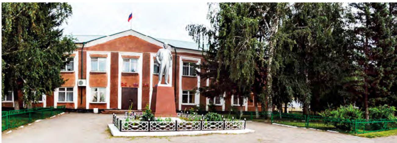
Здание районной администрации
