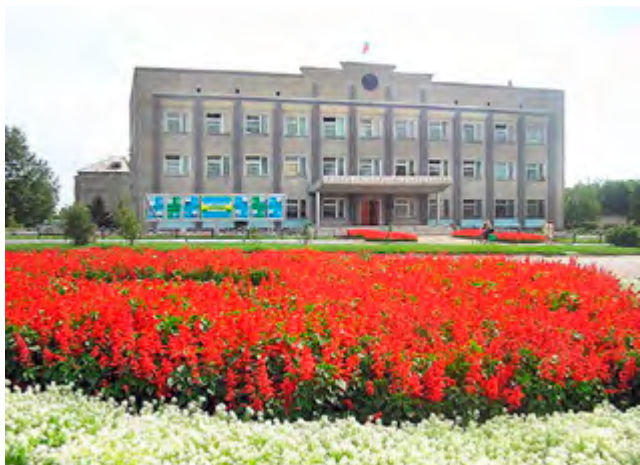
Здание районной администрации
