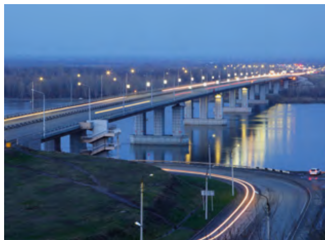
Мост через Обь
