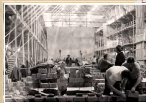
На строительстве коксовой батареи-2, 1982 год
