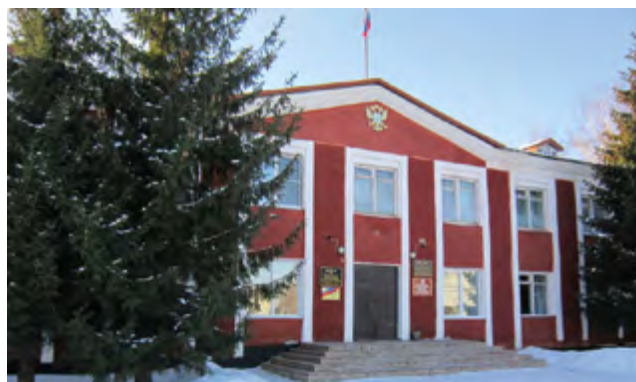
Здание районной администрации
