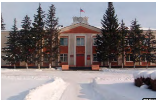
Здание районной администрации
