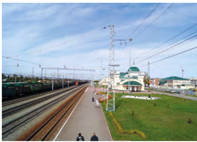
Станция Алтайская – крупный железнодорожный узел
