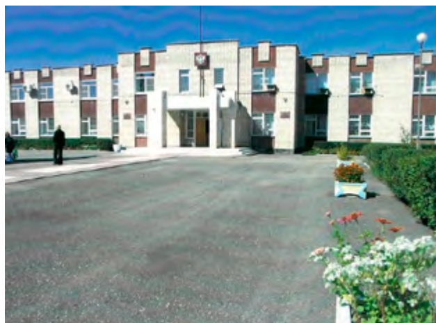
Здание районной администрации
