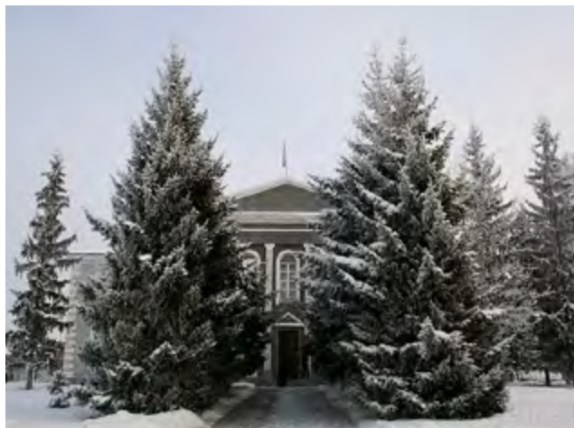
Здание районной администрации
