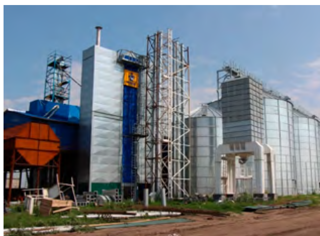
Зерноперерабатывающее производство КХ Апасова Н.И. в с. Нижнеозерное
