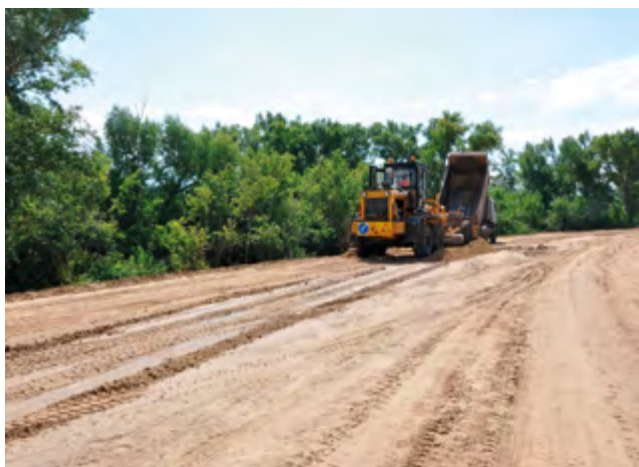
Строительство внутрирайонных дорог
