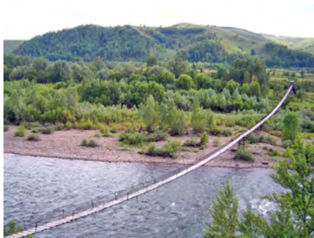
Подвесной мост через реку Чарыш
