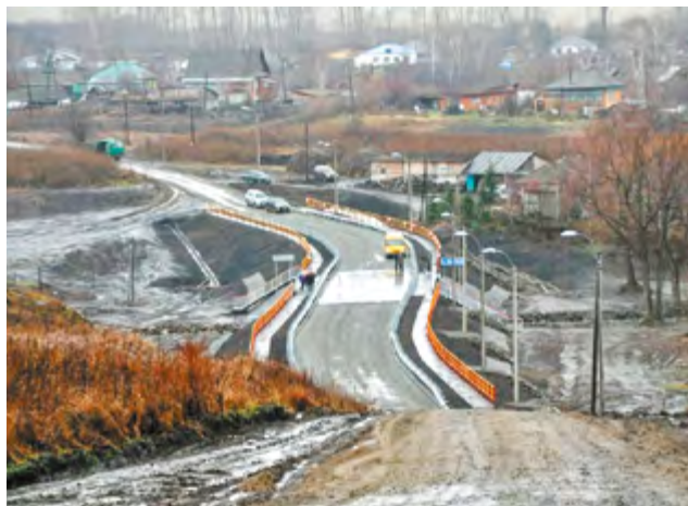
Новый мост через р. Каменку
